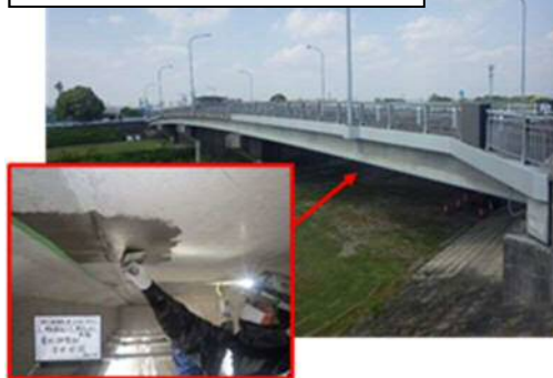
点検で発見された異常箇所速やかな修繕の実施
