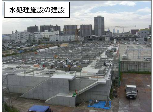
水処理施設 (土木) の増設工事
