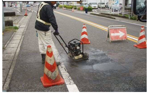
道路パトロール等で発見した路面損傷の速やかな補修の実施
