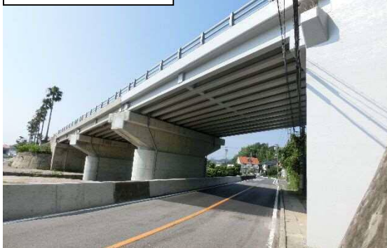
コンクリート巻立てによる橋脚の耐震化
