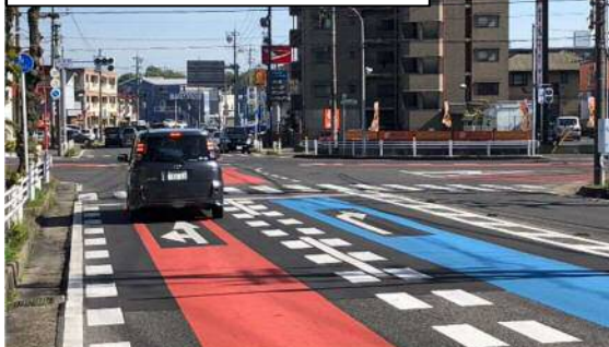
事故危険箇所における速効対策(カラー舗装)
