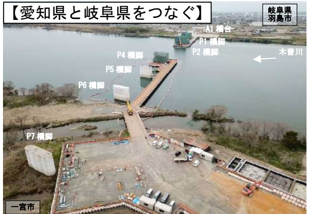
一般県道羽島稲沢線(新濃尾大橋)
