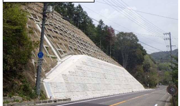
落石等危険箇所の解消のため、法面補強工や落石防止施設の設置を実施
