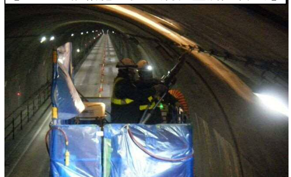
点検で発見された異常箇所速やかな修繕の実施
