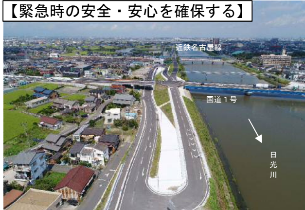
一般県道平和蟹江線(防災道路)
