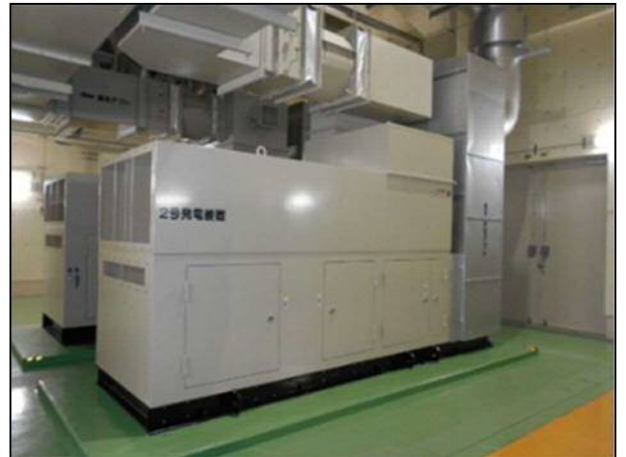
非常時の電源確保のための自家発電設備
