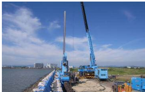
豊橋海岸 杉山地区（豊橋市）
