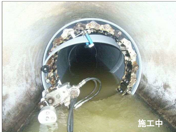
管更生工法による管きよの耐震補強工事
