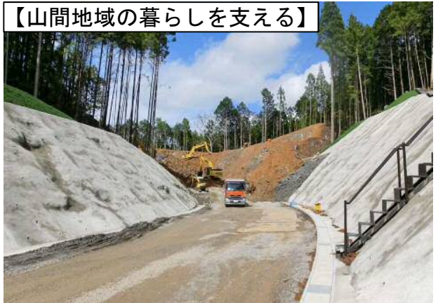
国道257号(清崎工区)
