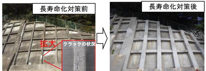
法枠に発生したクラックを補修
