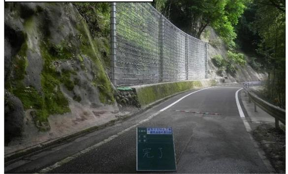
落石等危険箇所の解消のため、法面補強工や落石防止施設の設置を実施
