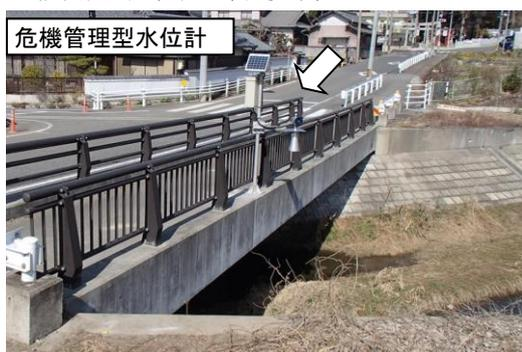
洪水時の水位情報を住民に提供する危機管理型水位計の整備
