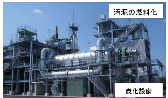
脱水汚泥を炭化により燃料化し、
